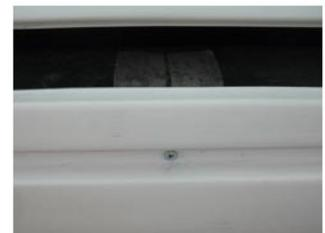
2/ Fixer à l'aide d'une seule vis au centre pour l'instant, présentez les 2 crosses pour vérifier le centrage puis posez les 2 autres vis de maintien du bandeau central. (Rep 2 sur les croquis)
